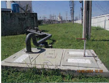
ภาพที่ 2-11 จุดระบายน้ำทิ้งจากบ่อบำบัดน้ำทิ้งรวมไปยังระบบบำบัดน้ำเสียส่วนกลางของนิคมฯ
