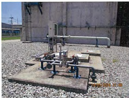
ภาพที่ 2-26 จุดระบายน้ำฝนที่เชื่อมต่อกับ ระบบระบายน้ำฝนของนิคมฯ
