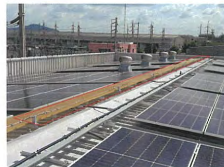
ภาพที่ 2-65 สาย Life Line บริเวณหลังคาอาคาร
