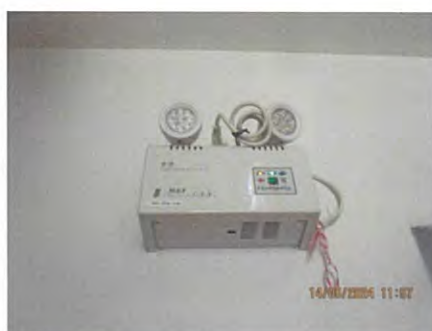
ภาพที่ 2-38 ระบบไฟส่องสว่างฉุกเฉิน
